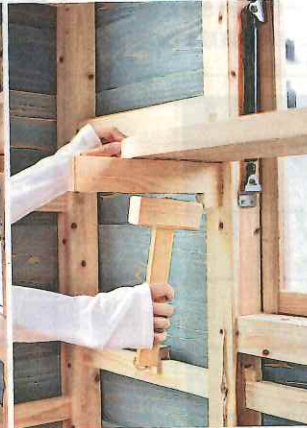
くさびを抜き差しして棚の高さを変えられる。
